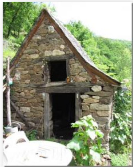
Figure 27 : Four à pain de M. Nicolau - © L. Campourcy
