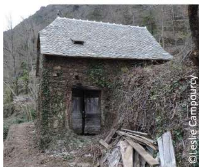
- la mise en place d'une « chiroptère » (passage à chauves-souris) dans le toit d'une grange lors de sa réfection.
